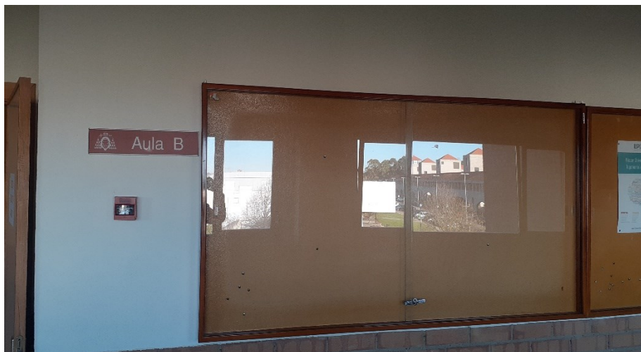
ACCESO AULA B PLANTA +1
