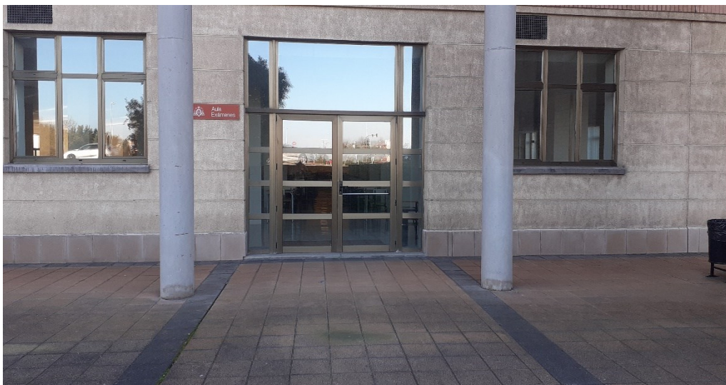
ACCESO 2(NORTE), AULA DE EXAMENES PLANTA -1
