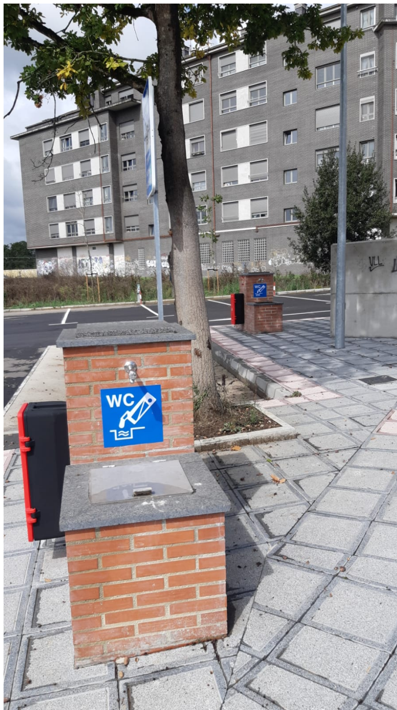
VACIADO AGUAS NEGRAS W.C. QUÍMICO
