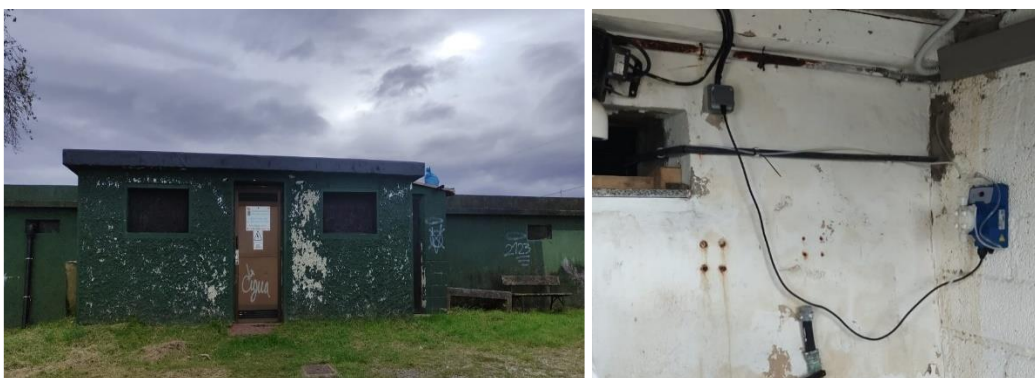
Figura 55. Señalización y exterior (izq.) y cloración (dcha.) depósito El Berrón
