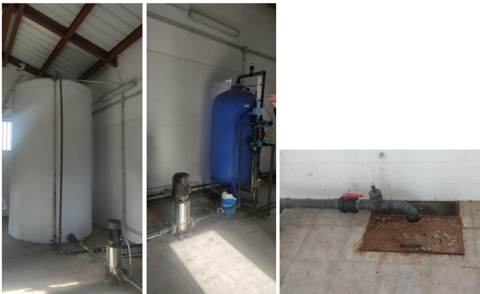
Figura 40. ETAP La Collada. Almacenamiento agua bruta (izq.) bomba y filtro arena (centro) y salida agua tratada (dcha.)
