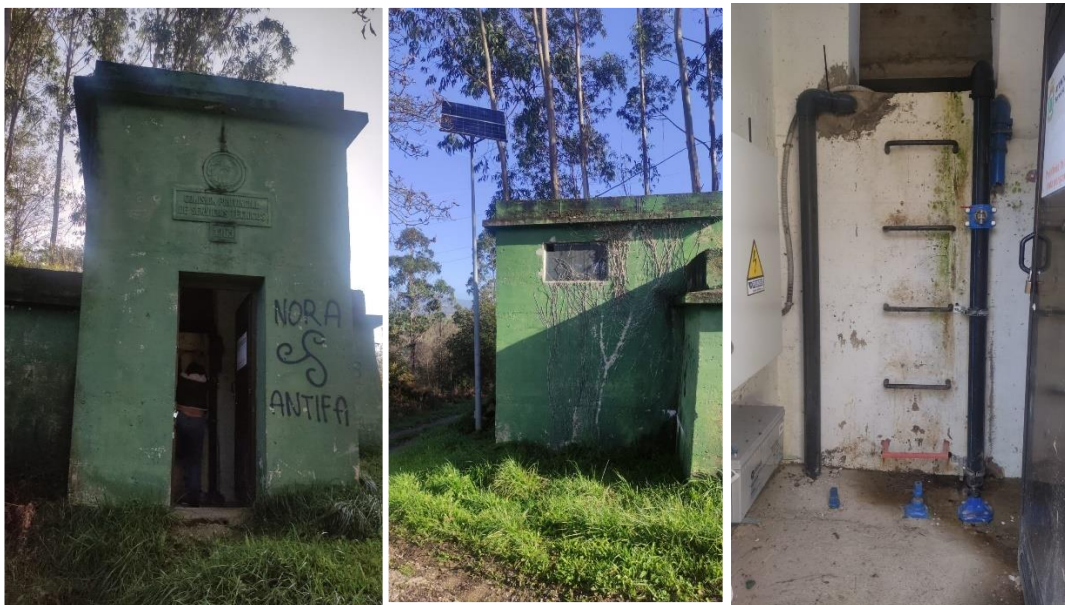
Figura 77. Exterior e interior depósito Corripo
