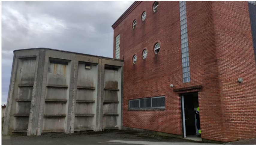
Figura 58. Exterior depósito Granda I
