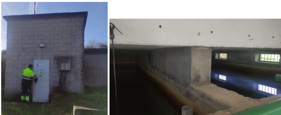
Figura 47. Exterior, señalización e interior depósito de Muncó
