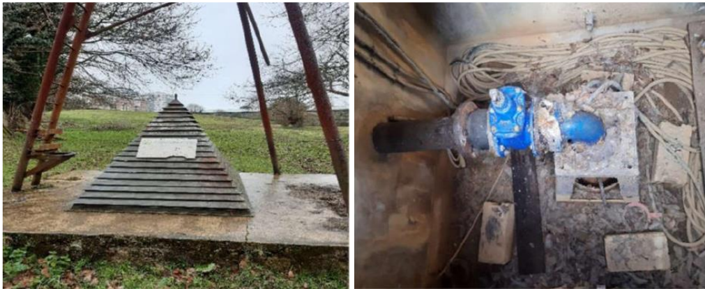
Figura 7. Sondeo Bergueres. Fuente: Informe TRAGSA “Servicio técnico de auditoría a los sistemas de abastecimiento en baja de los municipios de Noreña, Gozón y Siero”
