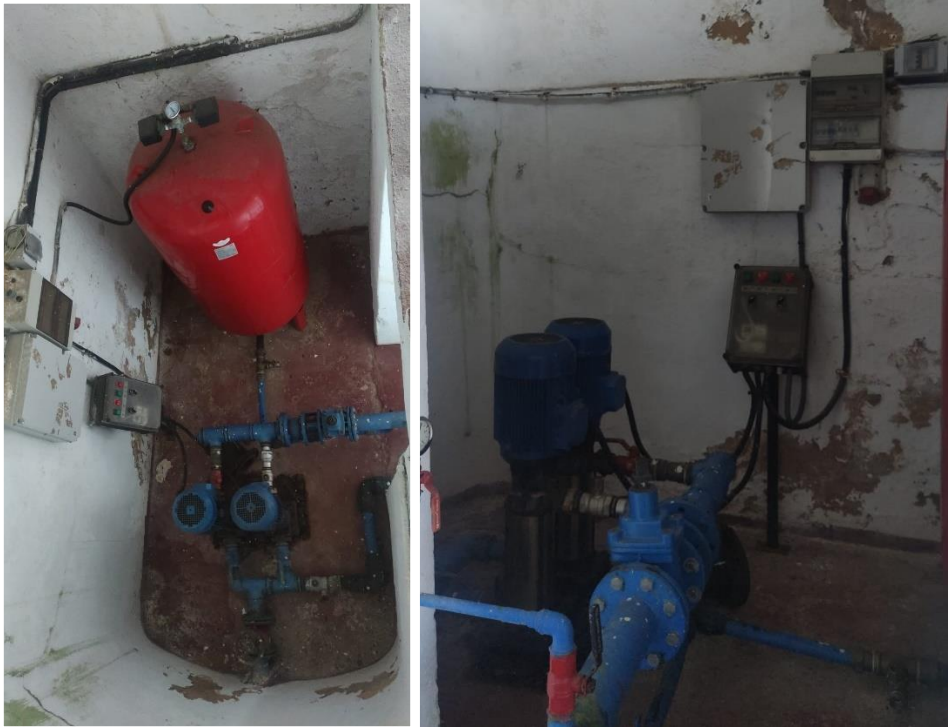
Figura 72. Grupo de presión a zona alta Castiello
