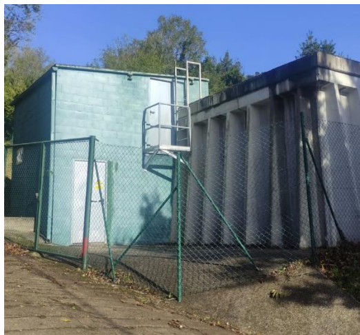
Figura 53. Exterior y señalización depósito Muñó
