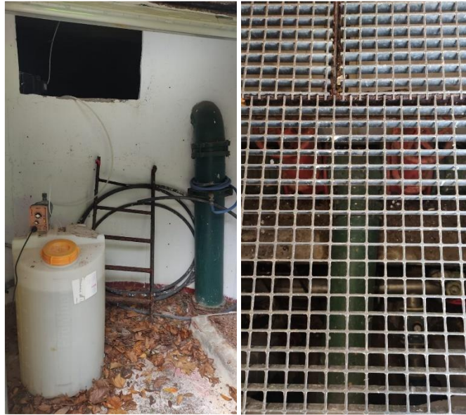
Figura 44. Cloración y entrada de agua de Careses (izq.) y entrada de CADASA (dcha.)
