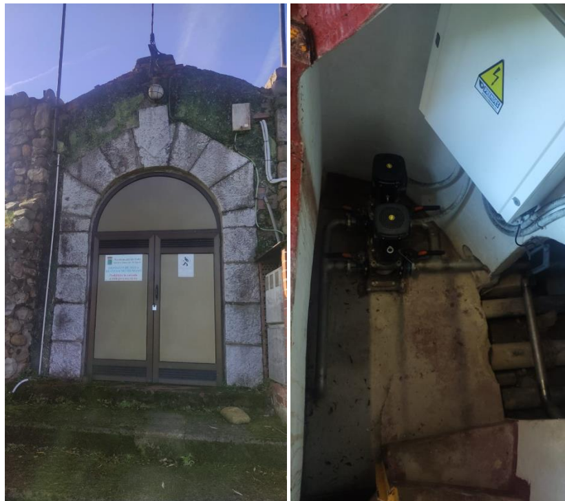
Figura 76. Exterior e interior depósito El Cuto
