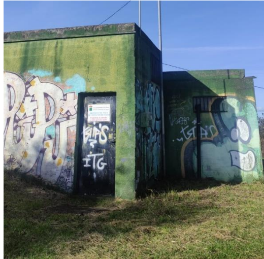
Figura 50. Exterior y señalización depósito La Teya
