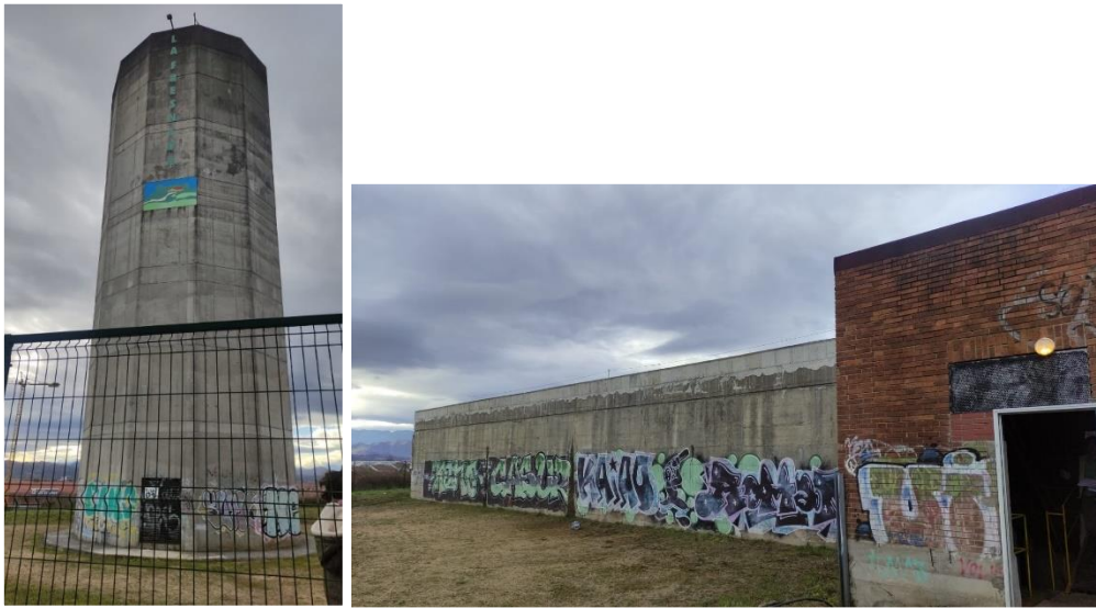
Figura 82. Vallado y exterior depósitos La Fresneda I y II
