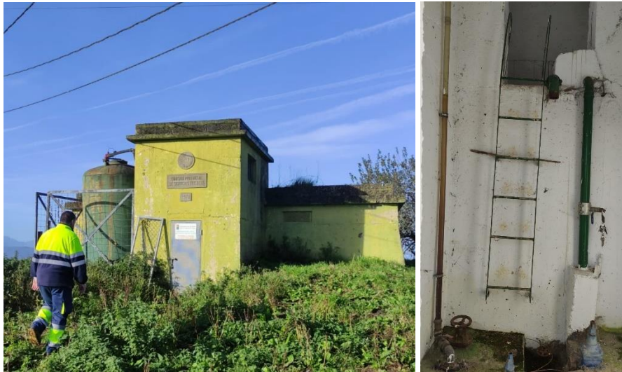
Figura 79. Exterior e interior depósito Magdalena
