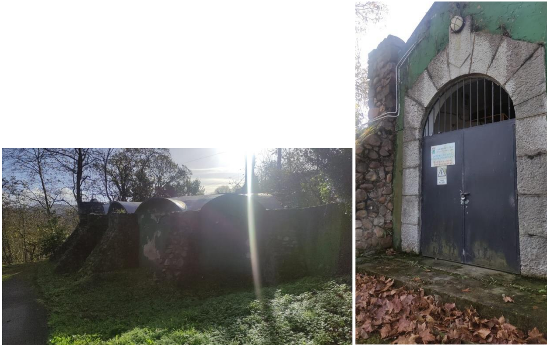
Figura 74. Exterior y señalización depósito Areñes
