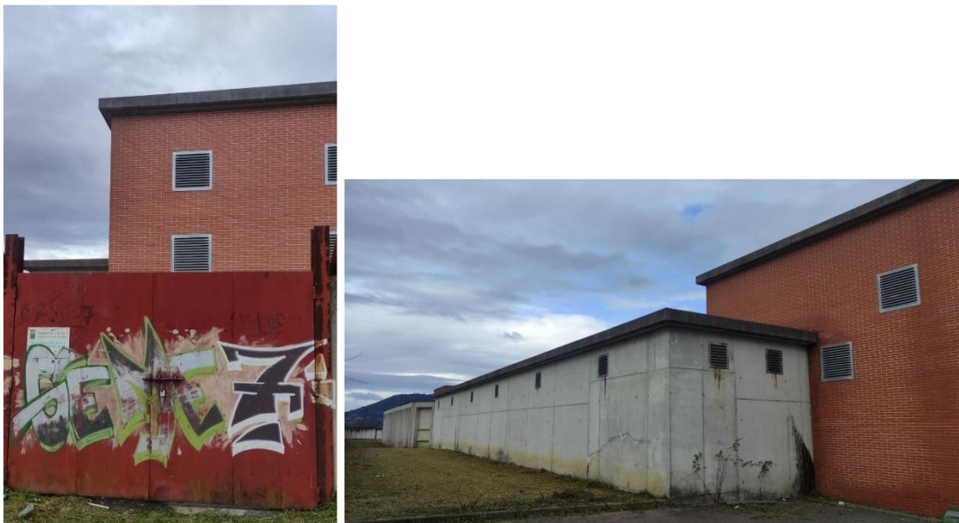
Figura 57. Exterior y vallado depósitos Granda I y II
