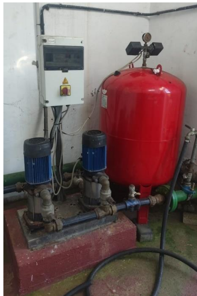
Figura 49. Grupo de presión depósito Muncó
