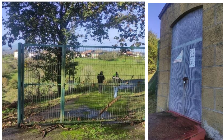
Figura 71. Vallado y entrada depósito Castiello
