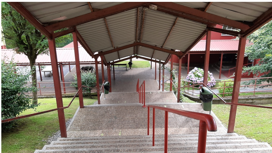
DENTRO DE RECINTO DE INSTITUTO ESCALERAS DE ACCESO A PUERTA
