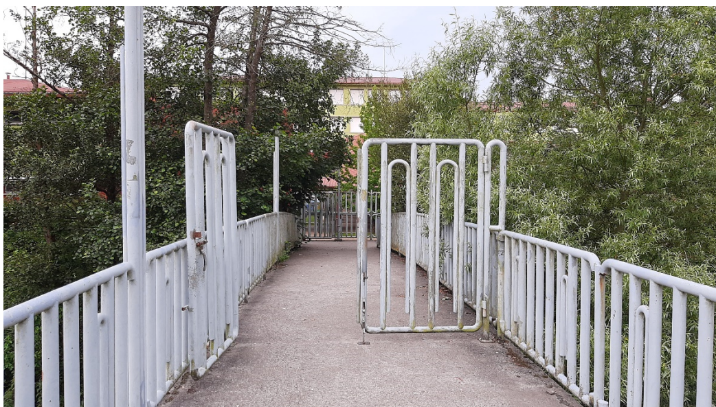
ACCESO POR PASALERA SOBRE RIO EN APARCAMIENTO DE CALLE ASTURIAS
