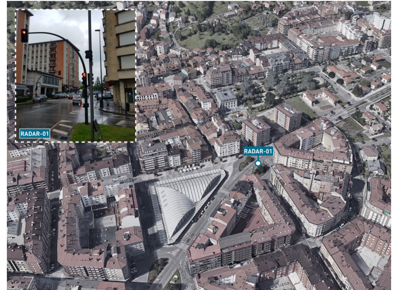
Imagen 45. Localización e imagen del radar instalado en la N-634.
