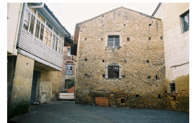
Vista de la fachada este a calle trasera
