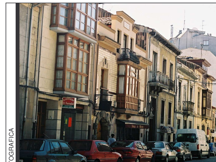
Vista general del frente a la C/ Marquesa de Canillejas, desde el norte.
