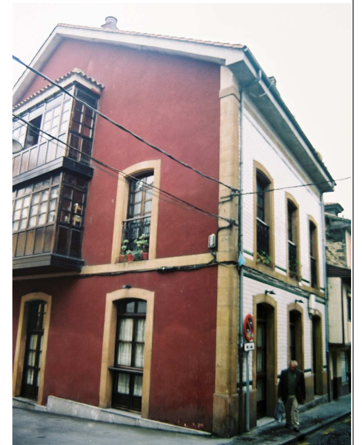
Esquina que conforman la fachada a la C/ San Antonio (derecha) y el frente a callejón (izquierda de la foto).
