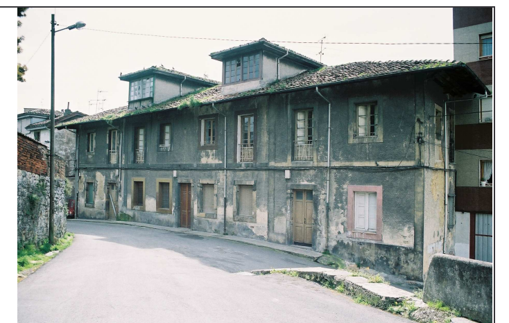
Vista general de la fachada delantera, con frente a la C/ Santa Ana en su encuentro con la C/ Pelayo.
