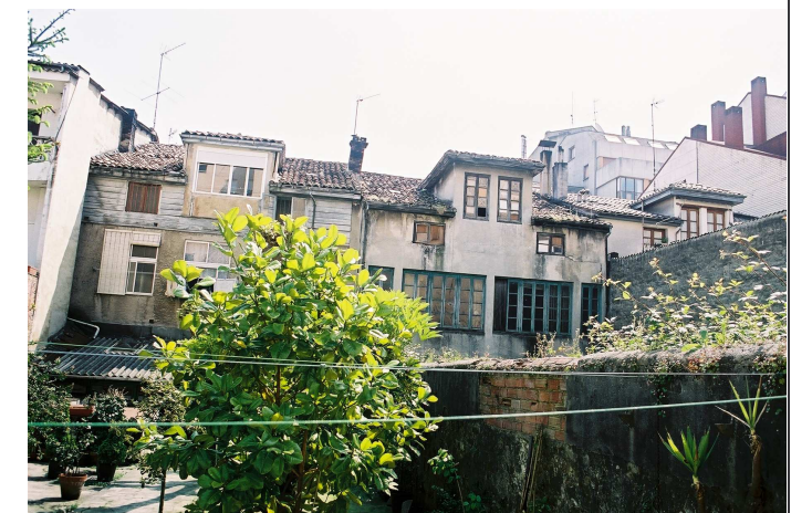
Vista de la fachada posterior. Pese a las reformas sufridas, se reconocen básicamente las formas originales.
