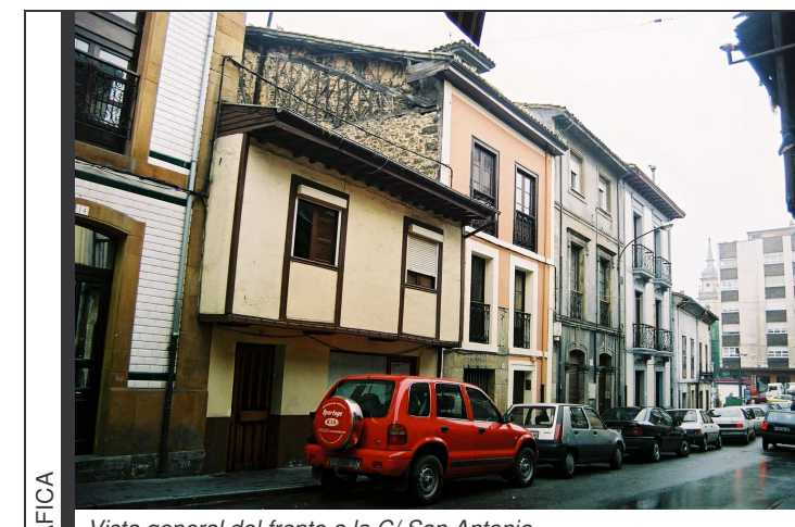
Vista general del frente a la C/ San Antonio.
