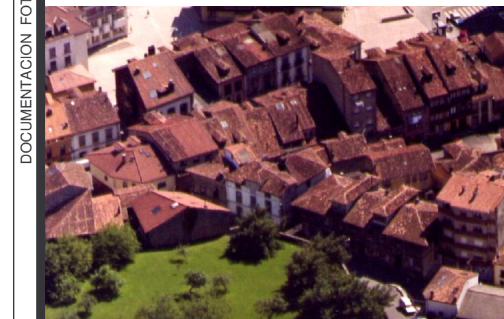
Vista aérea tomada desde el noreste, donde se observa el emplazamiento del edificio.
