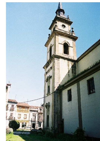
Vista de la torre oeste desde el interior de la parcela. Al fondo, la Calle Celleruelo.
