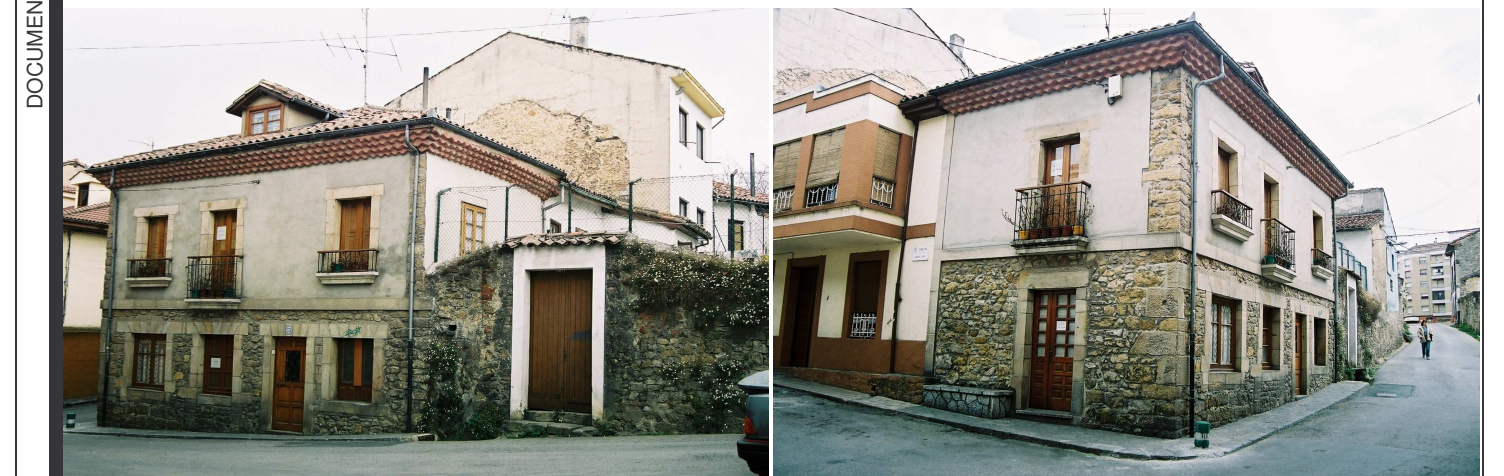
Fachada a Calle San Antonio y lateral a finca colindante. Al fondo puede apreciarse la elevación del edificio 03 y la presencia de la medianera.
