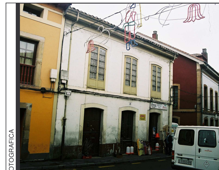
Vista de la fachada delantera, a la C/ San Antonio.
