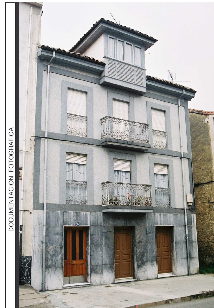
Vista de la fachada principal a calle Soledad.
