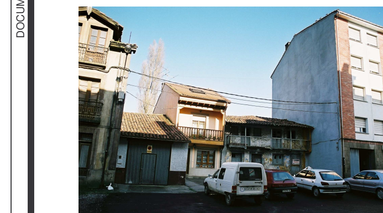
Vista general, donde se aprecia el exceso de volumetría y alturas del edificio colindante.
