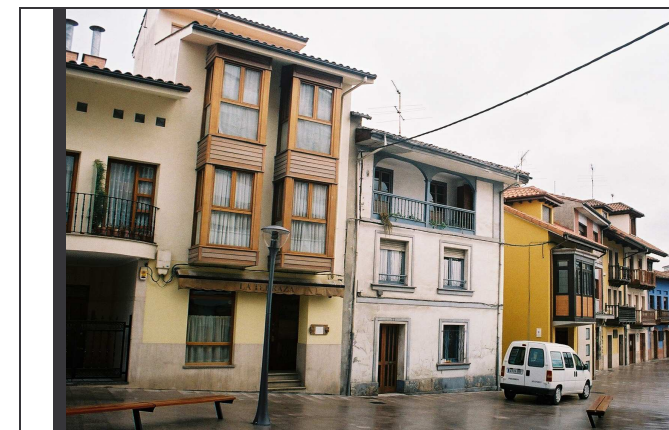
Vista general del frente a Les Campes, desde el oeste
