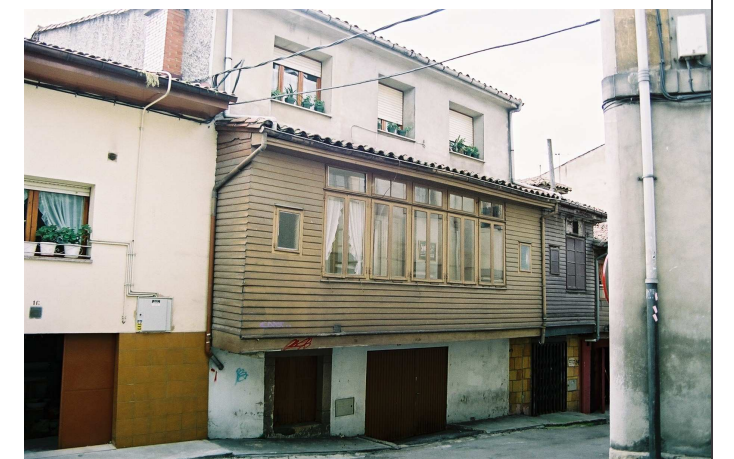
Fachada posterior a C/ Pelagos, donde se observa con claridad la ampliación moderna realizada por encima de la galería
