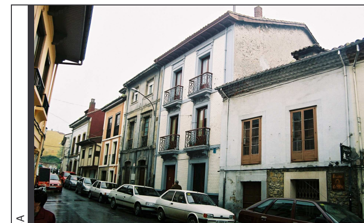
Arriba: Vista general desde la C/ San Antonio.
