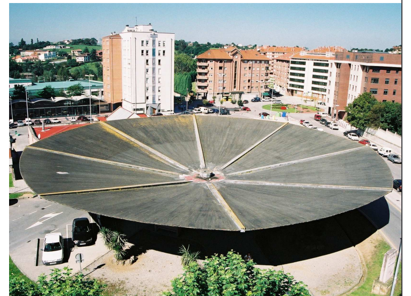
Vista elevada del elemento desde el este, donde se aprecia claramente la estructura nervada radial de su cubierta.
