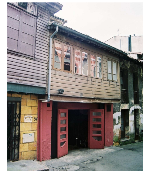
Fachada posterior, a C/ Peligros
