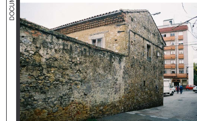
Imagen tomada desde el camino en dirección sur . Obsérvese el contraste producido por el edificio situado al fondo
