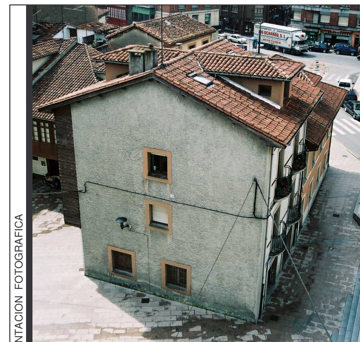
Vista elevada del edificio desde el norte
