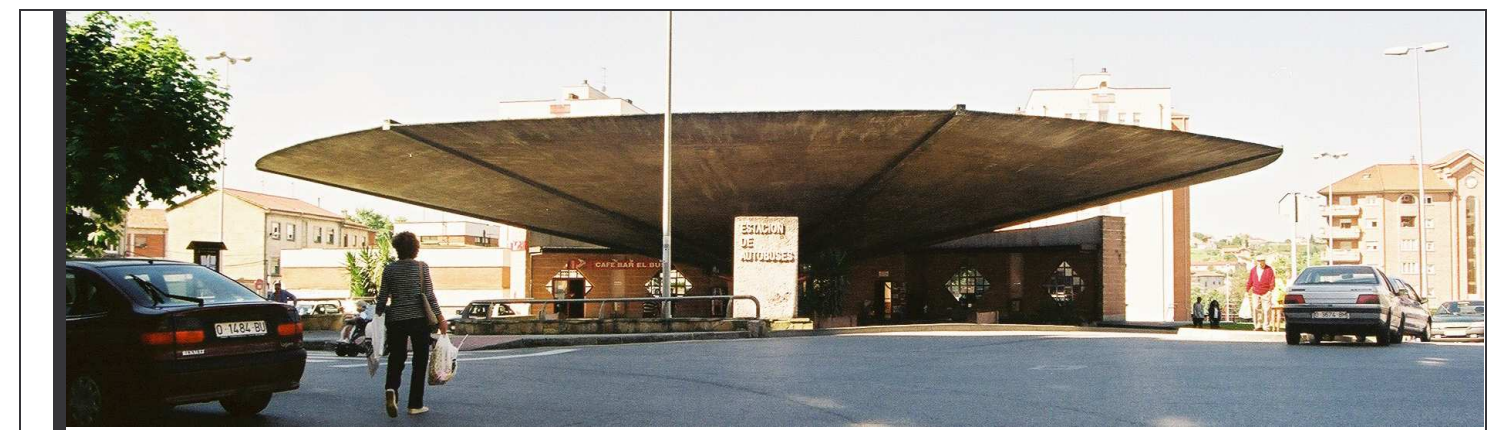
Vista general del "Paraguas" desde el noreste, con el edificio de la estación de autobuses inmediato al mismo.
