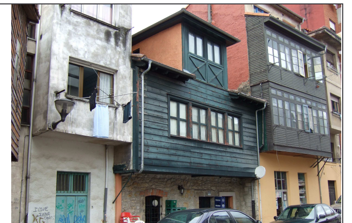
Aspecto de la galería en fachada a calle trasera
