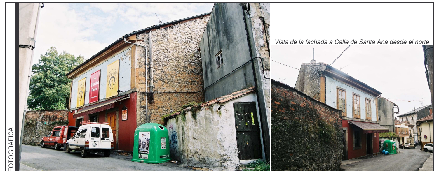
Vista de la fachada a Calle de Santa Ana
