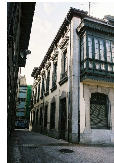
Fachada lateral este.
