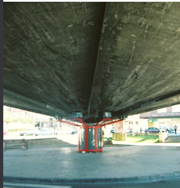
Vista a la cota de suelo del fuste central y la estructura nervada que arranca del mismo, con el añadido del elemento metálico soporte de luminarias, producto de la última intervención.
