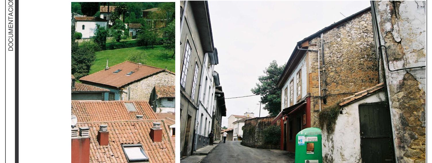
Vista de la cubierta desde el sur
