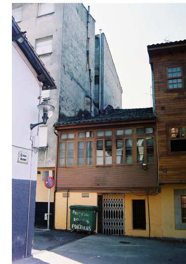
Fachada de servicio a C/ Peligros. Impacto visual y ruptura de la armonía ambiental producidos por la presencia del colindante.
