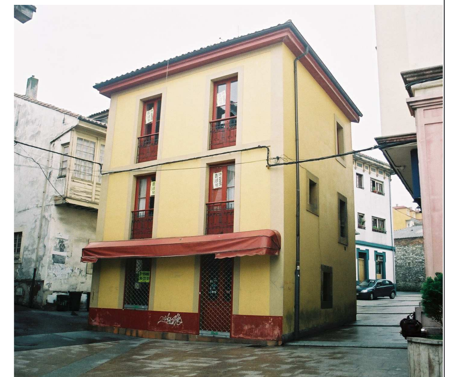
Vista general del edificio, con su fachada a la plaza y el frente lateral a uno de los dos pasos que comunican con el callejón posterior.
