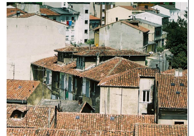
Vista elevada del frente posterior. Se aprecian claramente los casetones pasantes.
