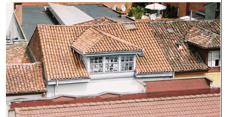
Faldón de cubierta y casetón correspondientes a la fachada delantera.
