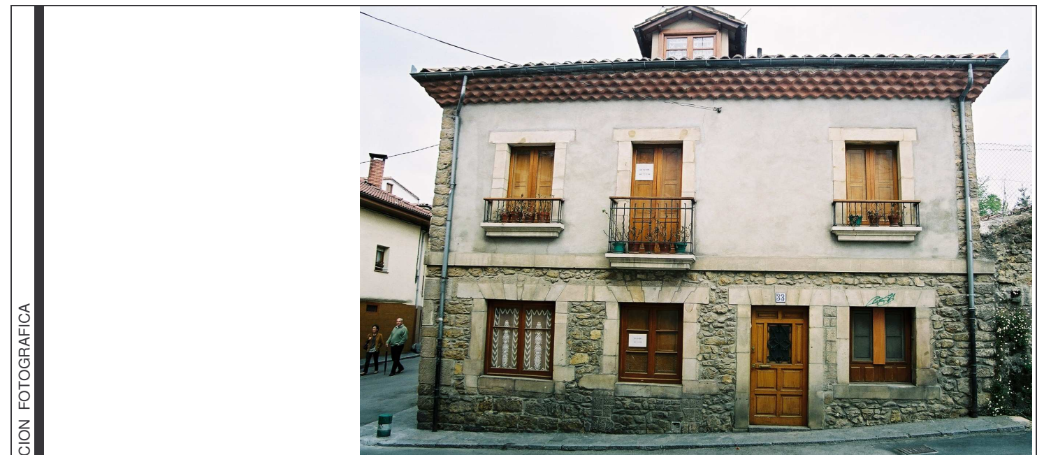
Vista de la fachada de acceso, a C/ San Antonio.
