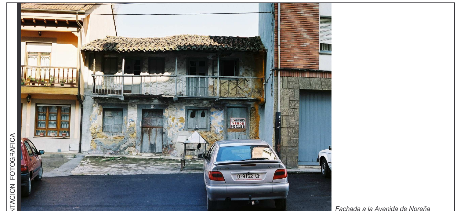
Fachada a la Avenida de Noreña
