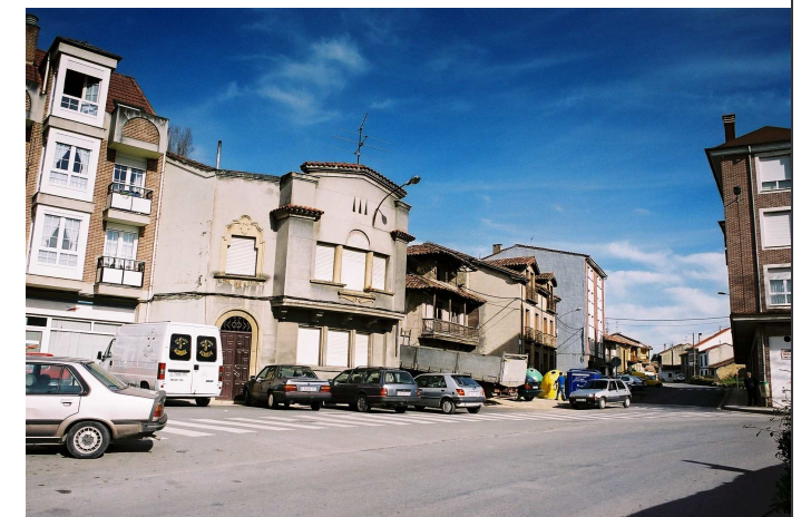
Vista general desde el oeste
