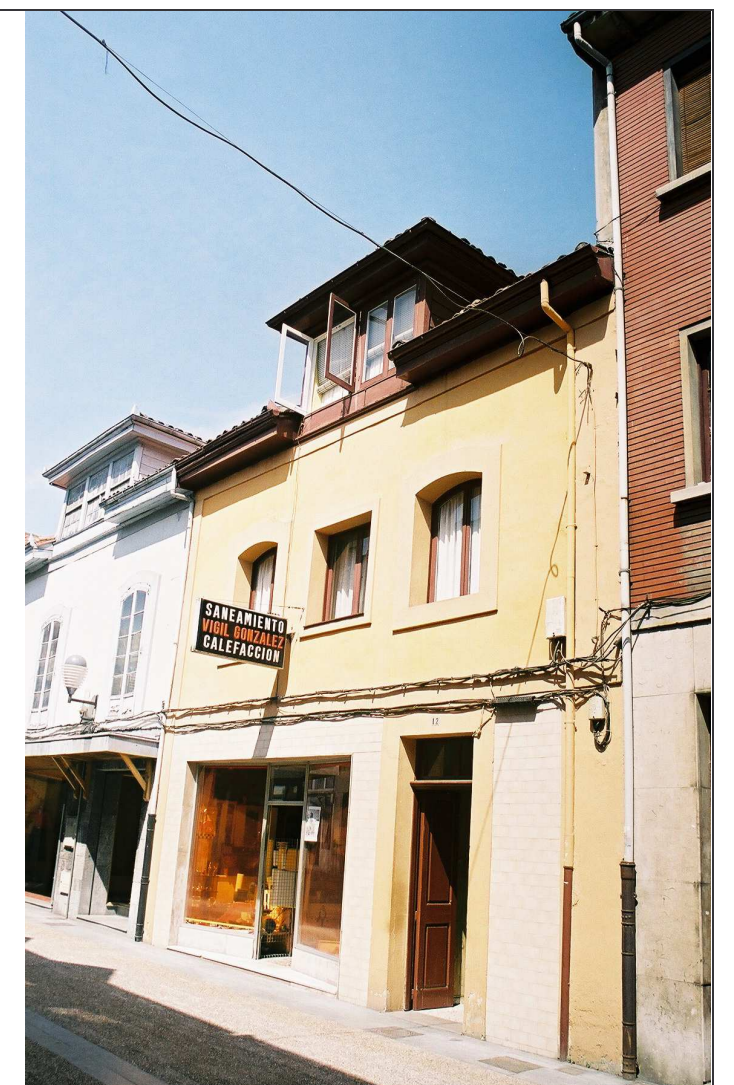
Fachada a la calle.
