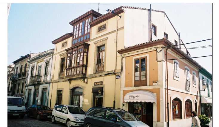
Vista general desde el suroeste.
