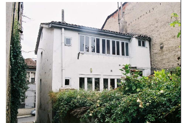
Vista de la fachada posterior desde el callejón.
