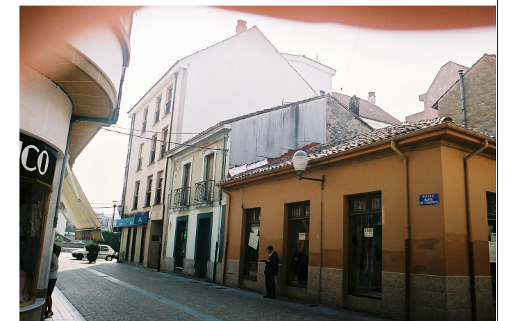
Vista de conjunto desde el oeste, donde se aprecia el desequilibrio de alturas y la excesiva pendiente de la cubierta del edificio colindante.
