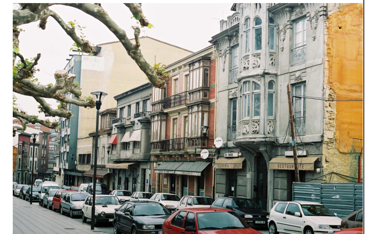
Perspectiva de la C/ Florencio Rodríguez desde el este. Al fondo, la medianera del edificio n o 3 de la calle.
