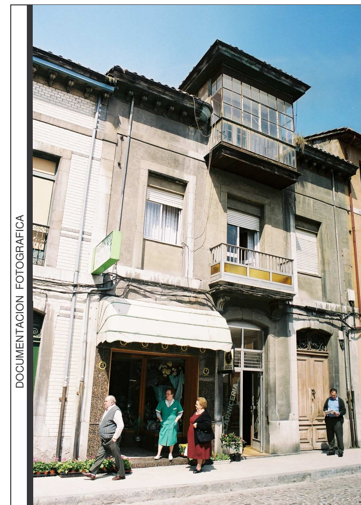
Fachada a la C/ Marquesa de Canillejas. Lo más significativo es la desaparición parcial del mirador y la transformación de huecos en planta baja y primera.
