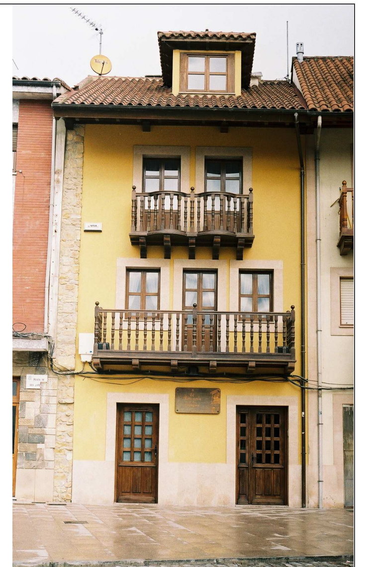
Fachada a la plaza.
