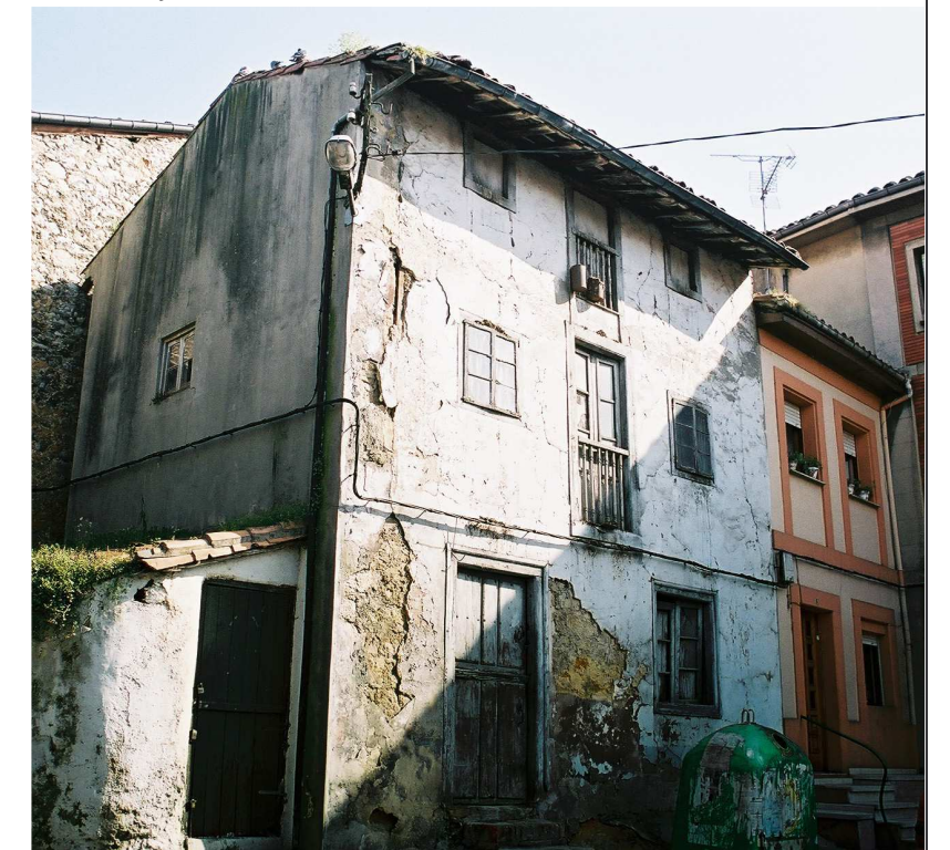
Vista de conjunto del edificio
