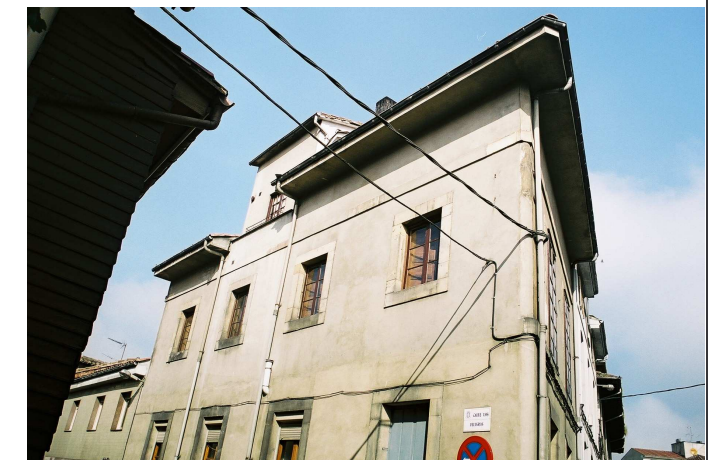
Vista de la fachada a C/ Peligros, con el casetón añadido por encima de la cornisa sin relación aparente con el orden inferior.
