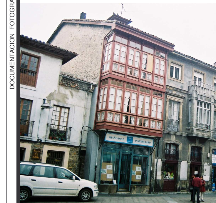
Fachada posterior, dando frente a la Plaza del Cabo Noval
