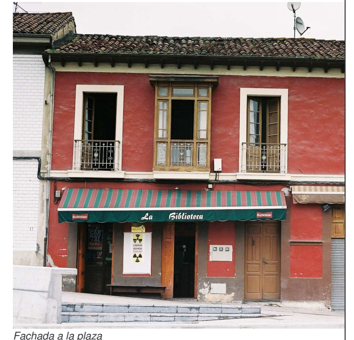
Fachada a la plaza
