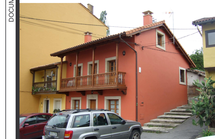
Vista general desde el este
