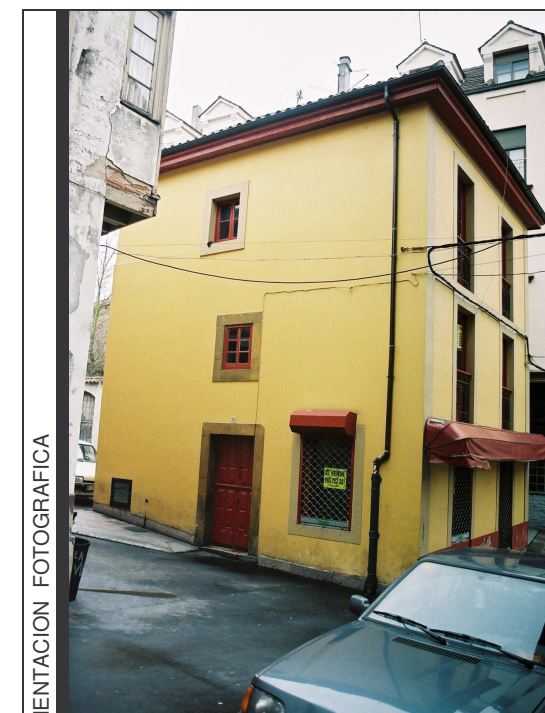
Fachada lateral norte; esquina a la delantera.
