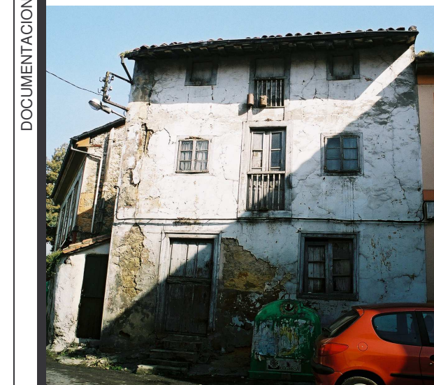
Imagen del estado actual de la fachada
