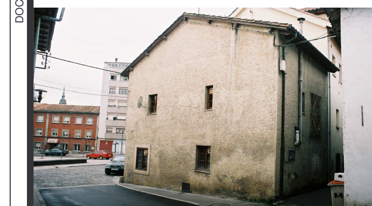
Fachada lateral y trasera a callejón, desde la Calle Cónsul.
