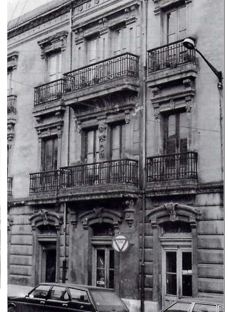
Fragmento de la fachada a la C/ Marquesa de Canillejas, en un estado anterior a la demolición.
