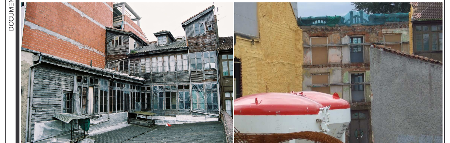
Vista de la fachada trasera antes de la demolición.
