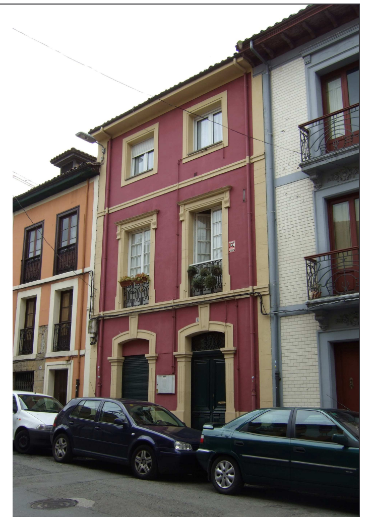
Detalle del frente principal, a la C/ San Antonio. Por él se produce el ingreso a la vivienda situada en las plantas superiores. Equilibrada composición de huecos en plantas baja y primera, y diversos elementos de interés en el recercado de los mismos (dinteles y jambeados)
