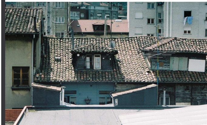
Faldón norte de cubierta, con vista parcial de la fachada trasera, con pequeña terraza, al patio de manzana.
