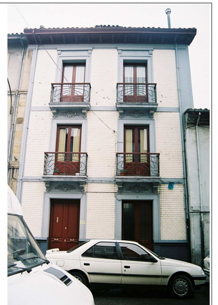
Detalle del frente principal (ingreso a viviendas), a la C/ San Antonio. Equilibrada composición de huecos, balcones modernistas y diversos elementos de interés en el revestimiento de la fachada.
