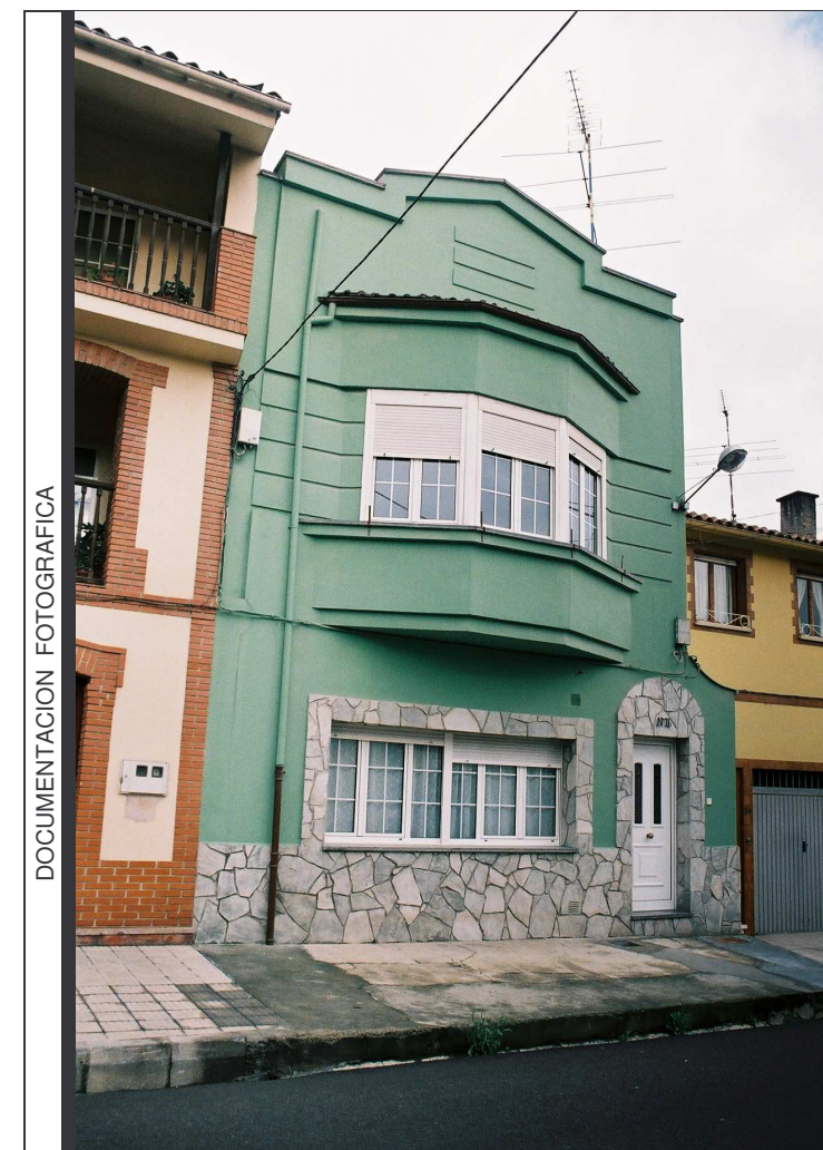
Vista de la fachada sur
