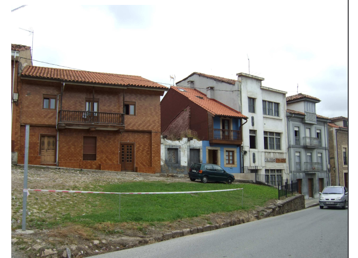
Vista general desde el oeste.
