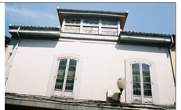
Detalle de la fachada a la calle.
