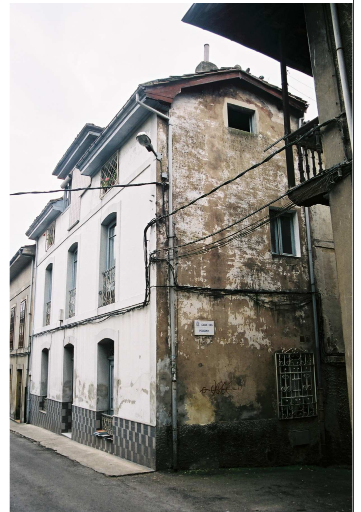
Vista desde el otro ángulo de la calle, en la que se distingue la esquina al callejón, sobre el que el edificio presenta un frente con tratamiento prácticamente de medianera.
