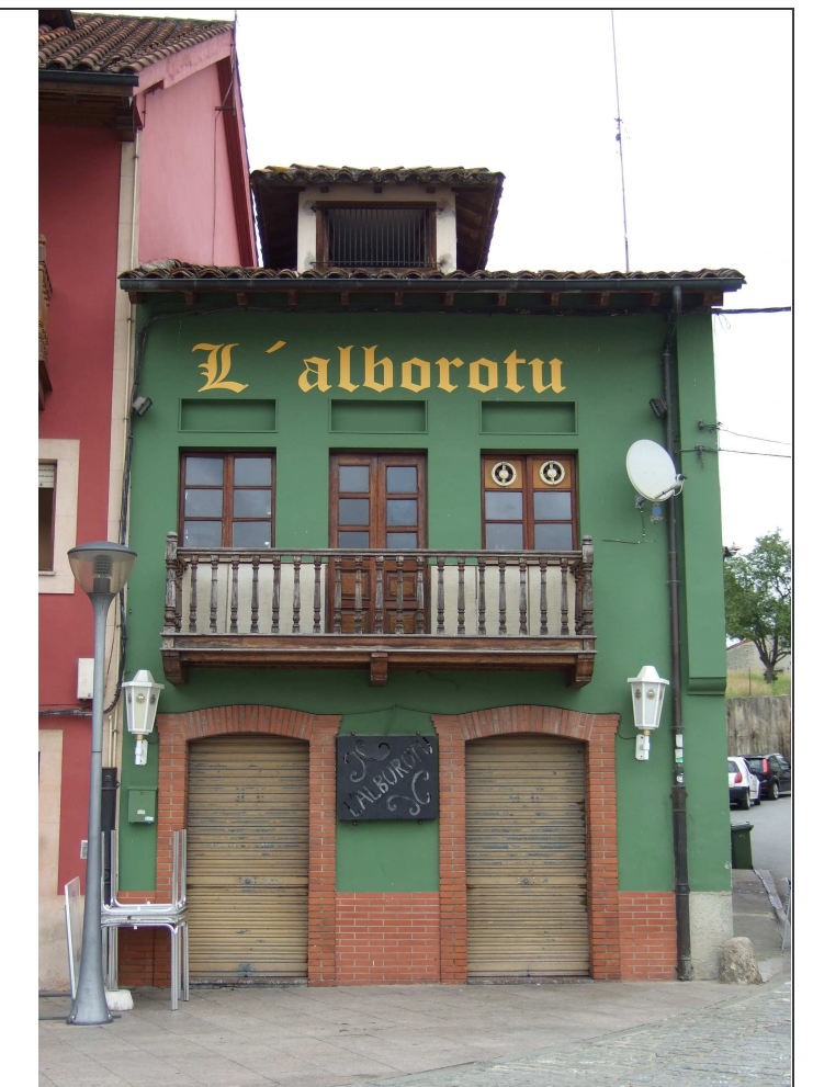
Fachada a la plaza.
