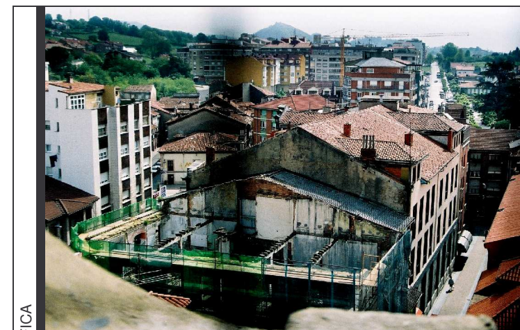
Vista tomada desde la torre este de la iglesia de San Pedro.
