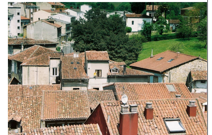
Vista de la cubierta tomada desde el sur.
