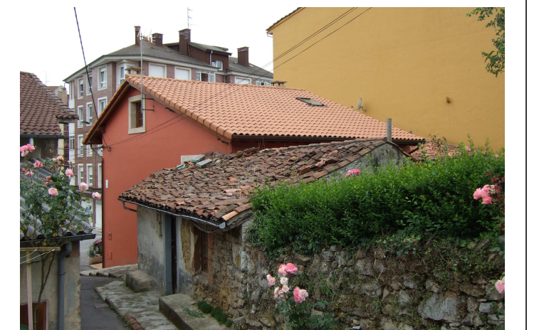
Vista tomada desde el Camino de las Margaritas.
