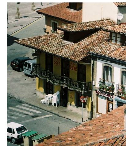
Vista aérea desde el sureste
