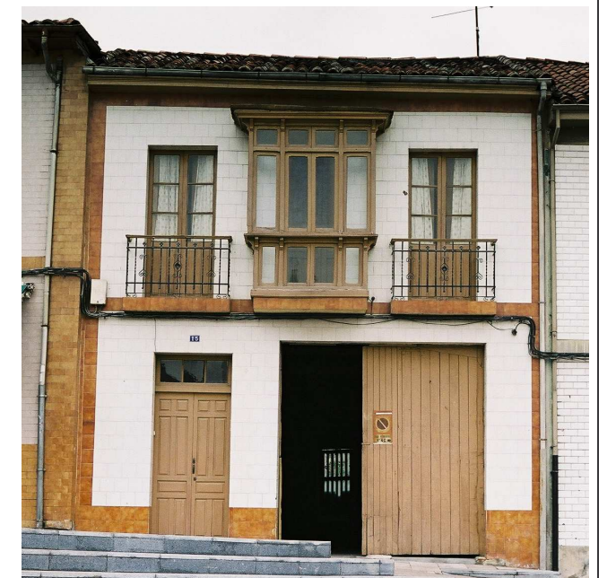
Fachada a la plaza
