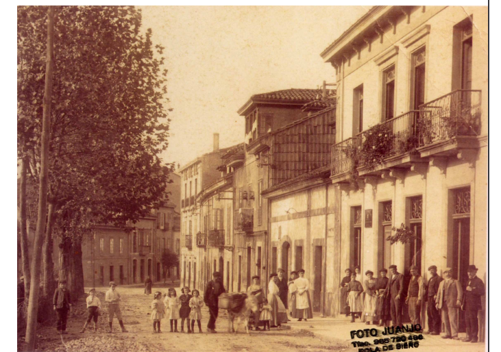
Fotografía de principios del Siglo XX. En primer término aparece el edificio catalogado antes de la reforma.
