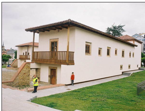
Estado actual del edificio (imagen tomada en julio 2007), tras la última rehabilitación llevada a cabo por el Ayuntamiento de Siero.
