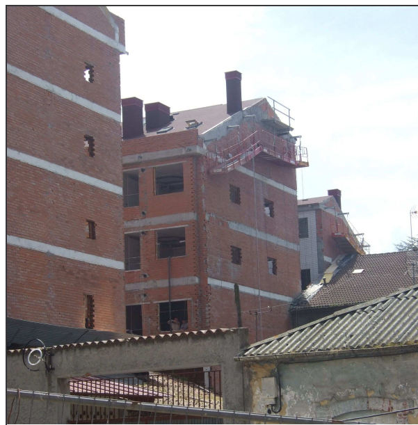
Estado actual (mayo 2008) del nuevo edificio, en una imagen tomada desde la Calle San Antonio.
