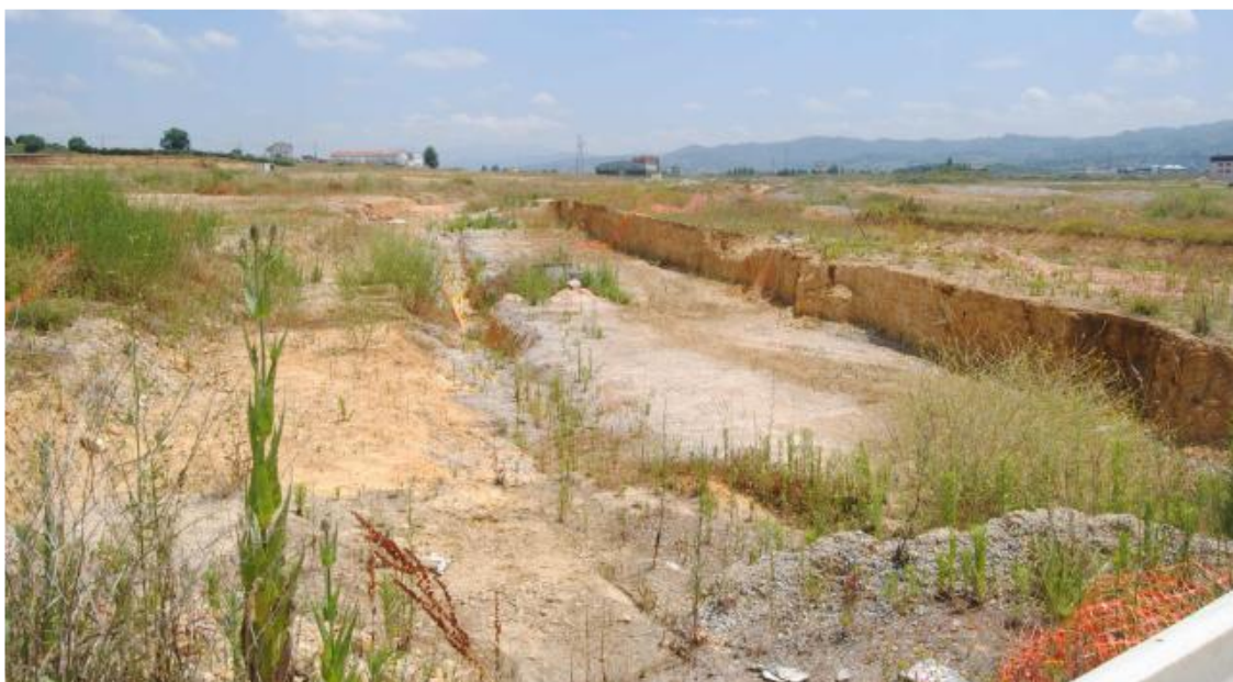
Vistas del Polígono de Bobes
