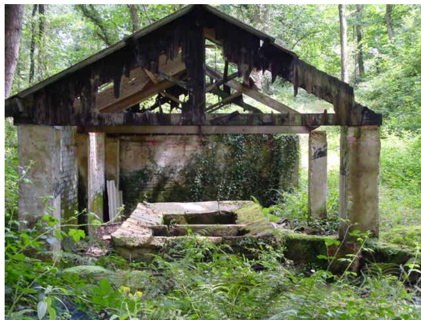
Vista lateral del lavadero.
