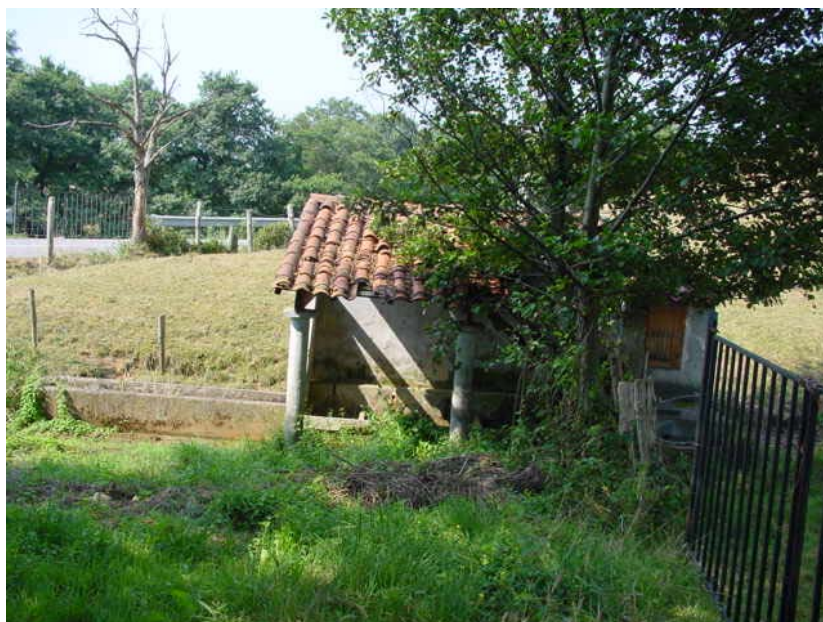
Vista frontal de la fuente y lavadero.
