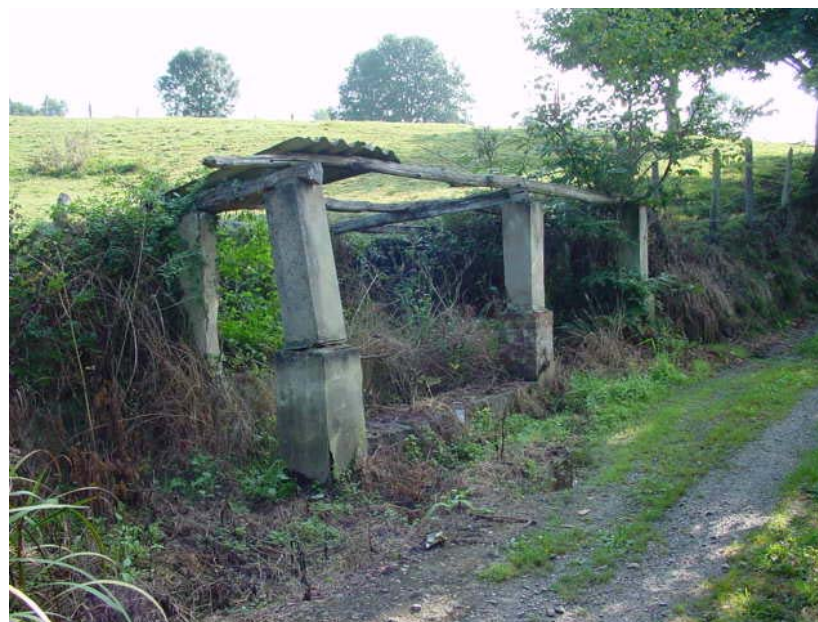
Vista del lavadero.
