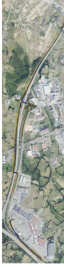
Imagen 81. Vista general de los futuro enlaces de acceso al Centro Comercial "Parque Principado".
